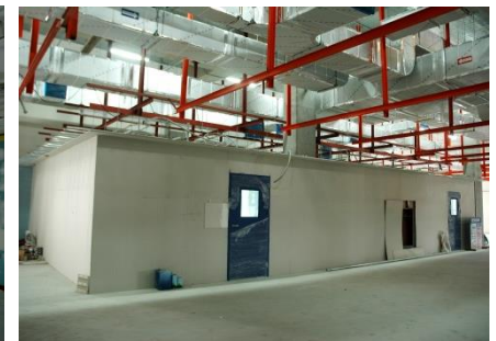
▼ SAMPLE 시공 - Dry Wall
